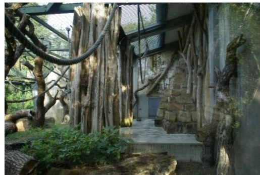
Abb. 12: Betonboden mit Steinpyramide
