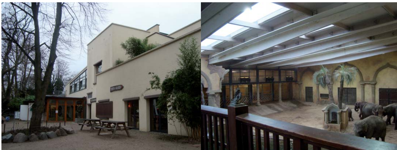
Umbau der Freilaufhalle 2006
