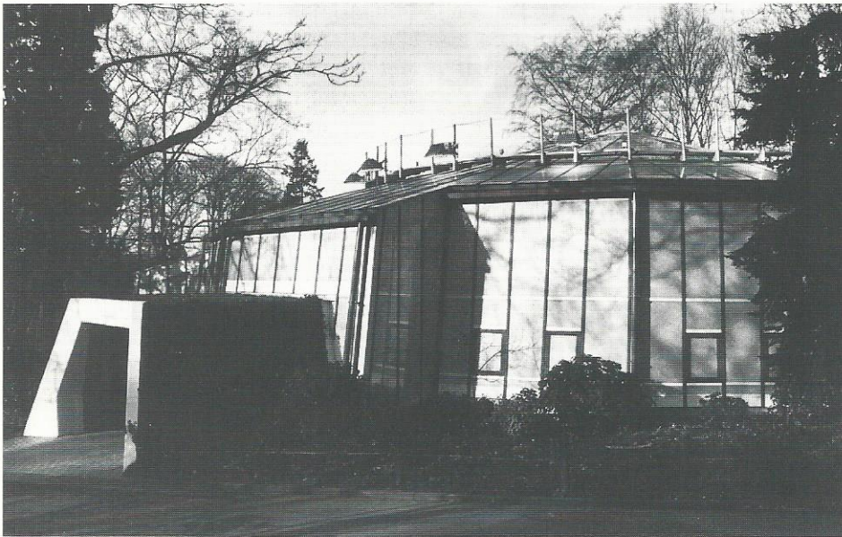
Abb. 1. Außenansicht der Freiflughalle mit Schleuse. Aufn.: Fischer
